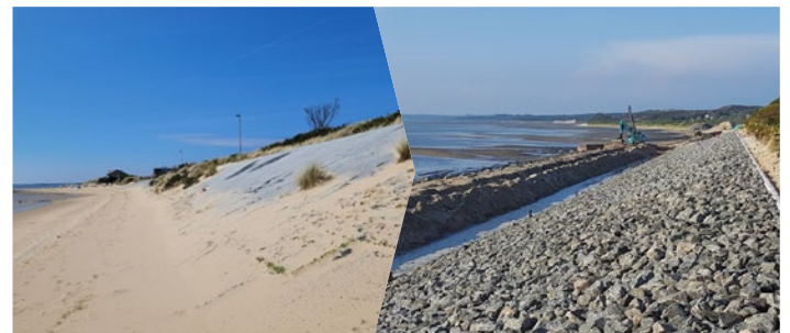
In einem ähnlichen Verfahren verstärkte der LKN.SH vor sieben Jahren das Deckwerk in der Blidselbucht zwischen List und Kampen.
